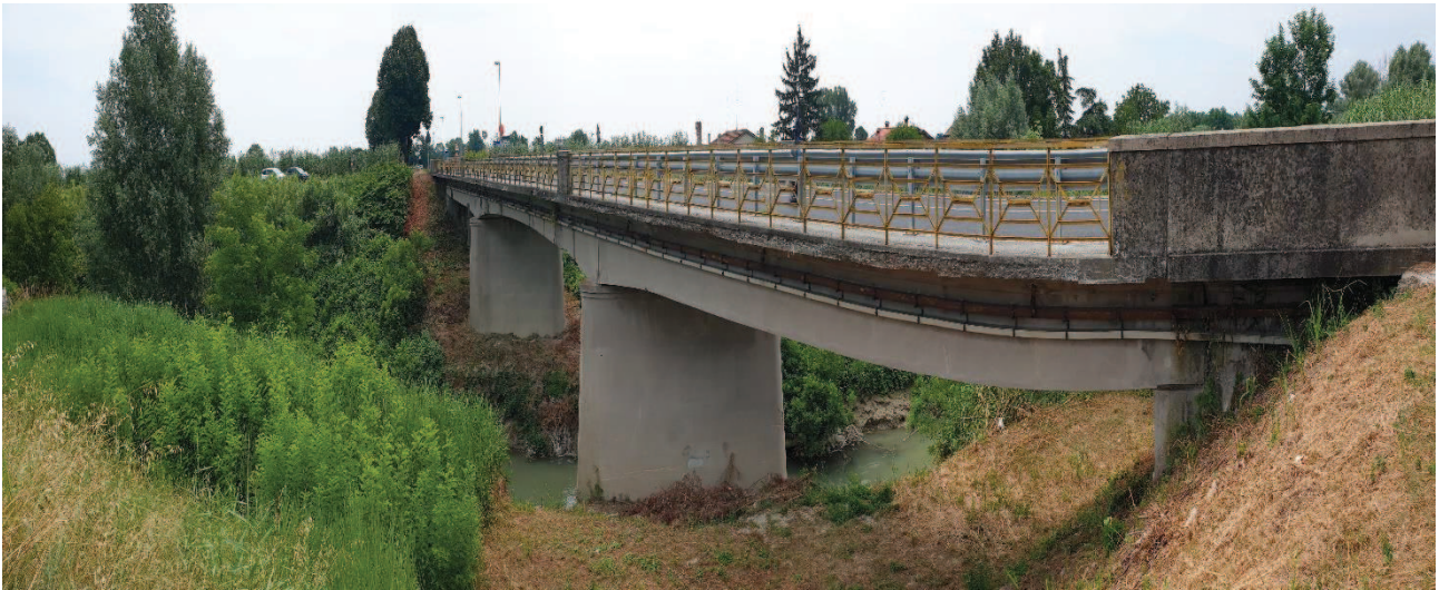
Figura 3-2: Ponte Montone. Inquadramento fotografico – Sponda Lato Ragone ponte visto da monte
